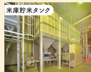
米庫貯米タンク
