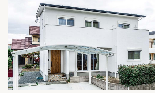
内装だけでなく、外壁も漆喰塗り。多少汚れがついても、雨で洗い流せるのでお手入れもほほいらないんだとか
